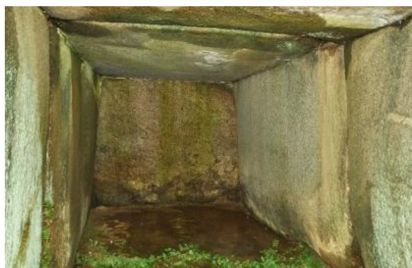
両側壁に残る縦長の溝
