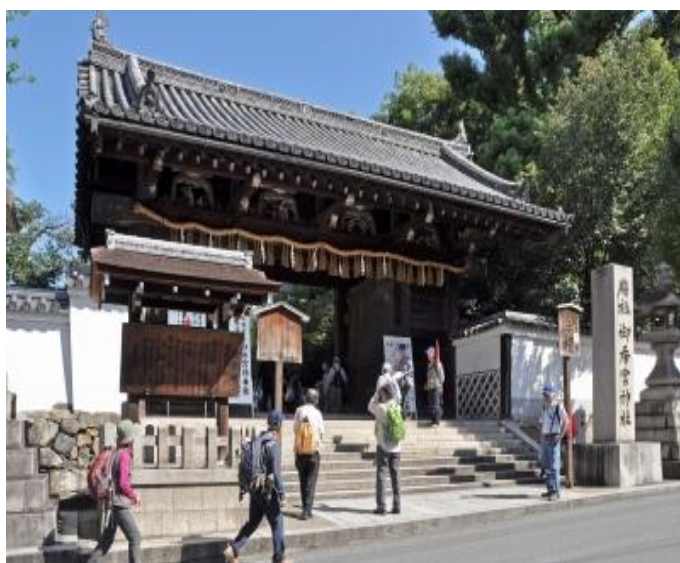
伏見城大手門が 移設された表門
